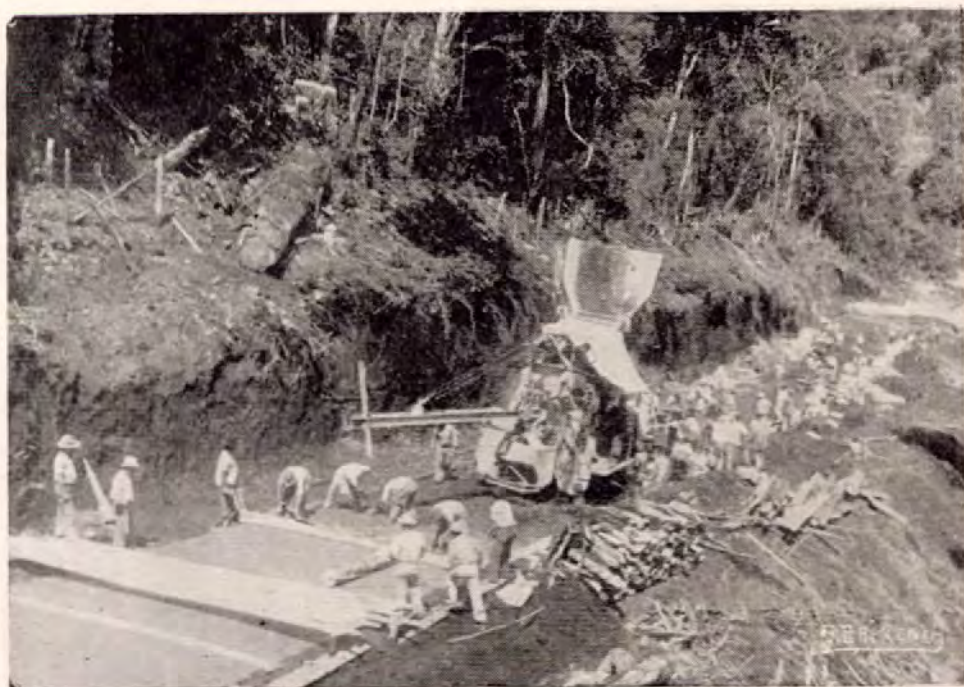
La carretera en construcción al volcán Poás, fue contratada con la empresa "El Ingenio", del ingeniero don Francisco Jiménez Ortiz. El turista puede llegar a la cumbre del volcán en una hora, a caballo, desde el punto en que termina la carretera.
