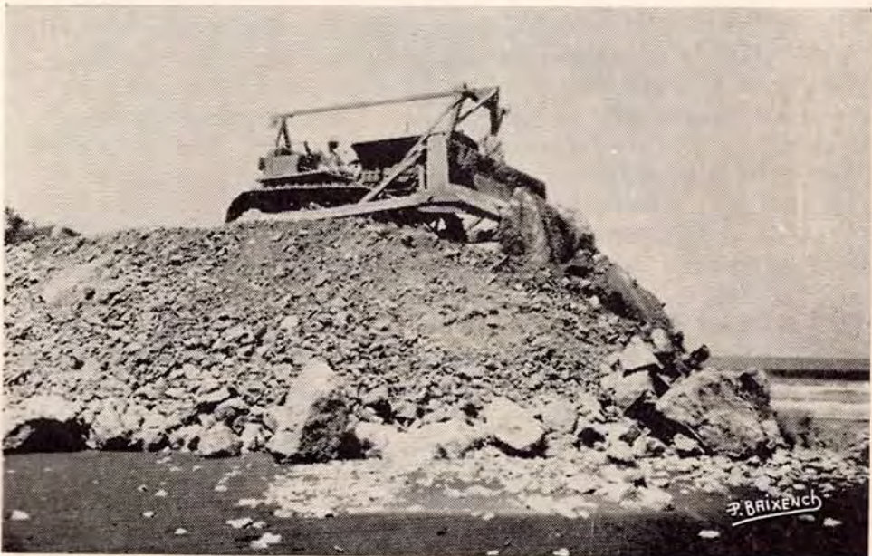
Una potente pala de vapor empleada por la Compañía Bananera de Costa Rica para remover la roca demolida con dinamita en el histórico Peñón de Punta Quepos.
