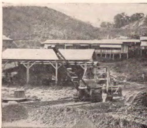
Otra vista de Quepos, en la que pueden apreciarse los increíbles trabajos allí realizados para instalar higiénicamente la población, transformando la montaña.
