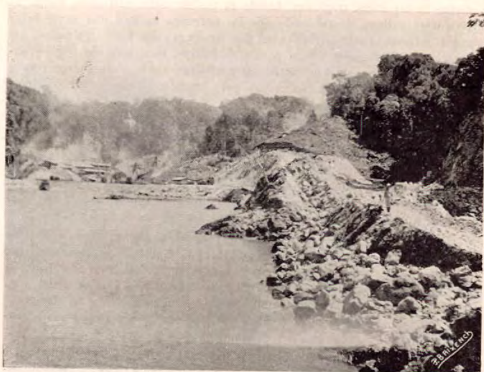
Otra sección de los trabajos de nivelación de Punta Quepos, donde los ingenieros de la Compañía Bananera de Costa Rica han tenido que volar con dinamita 70.000 metros cúbicos de roca.
