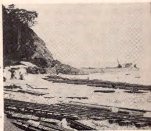
El muelle de Quepos en construcción. Todo el terreno que se aprecia en primer término, es relleno hecho en el mar con la roca del Peñón.
